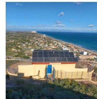
Instalación solar en EBAP Sañi (Cullera) para autoconsumo de la instalación
